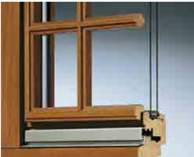
VSR: abnehmbarer Vorsatzsprossenrahmen
